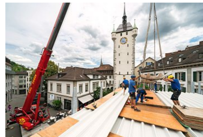
Das Containerdach wird erst abgedichtet, bevor darauf die Bar errichtet wird. Im Hintergrund der Stadtturm von Baden.
