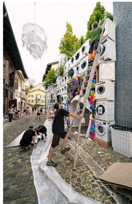
Mit Elan ins Finish: Der Aufbau ist kurz vor der Vollendung.
