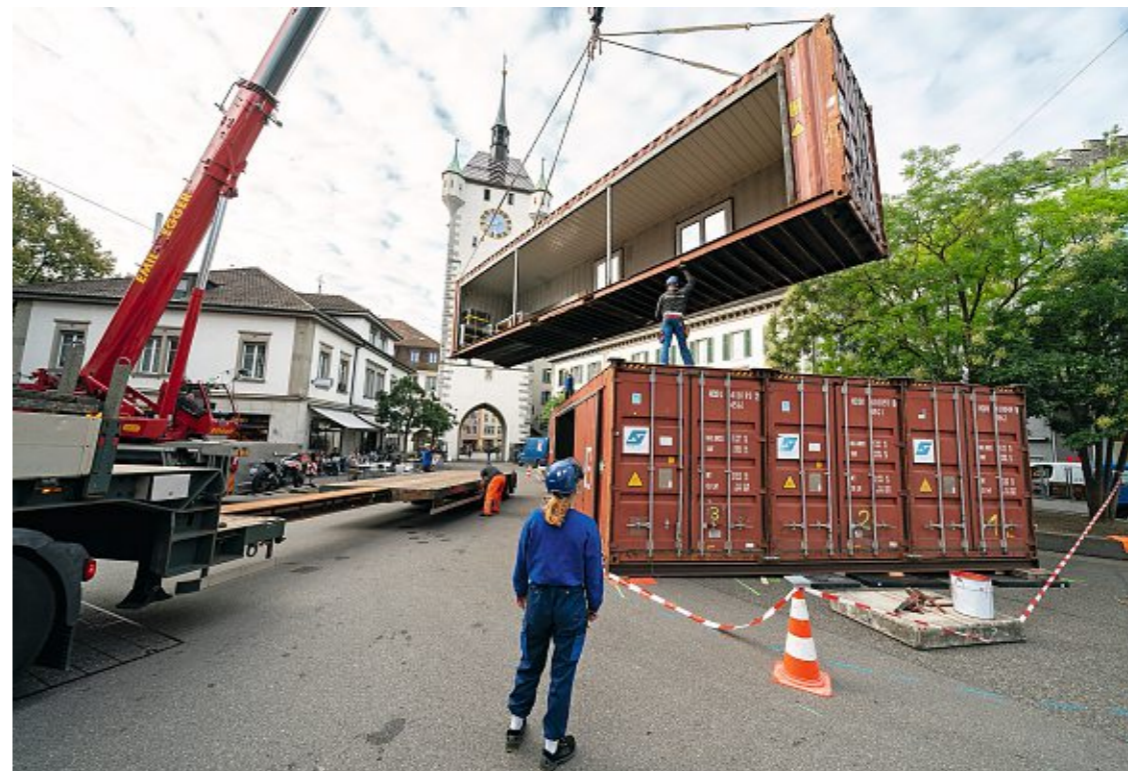
Die Hochseecontainer werden per Kran an ihren Bestimmungsort manövriert.
