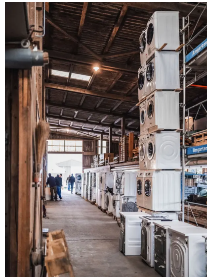
Sechs Waschmaschinen hoch wird die Fassade.
